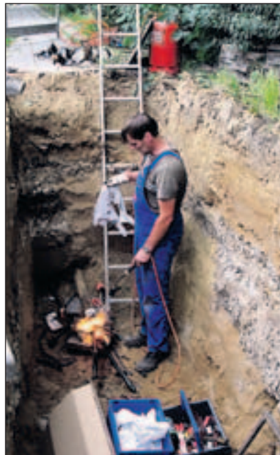
Gerhard Schröder von der Firma IMD repariert den Kabelschaden an der Adersheimer Straße. Foto: Hespos
